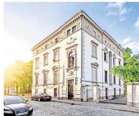
Kategorie Denkmal: Die Villa und Remise in der Chopinstraße 28 putzte das Unternehmen Perfas Immobilien neu heraus.
