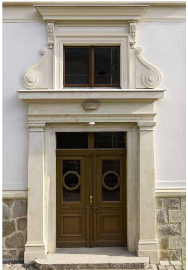
Rechts: Detail des historischen Eingangsportals nach der Rekonstruktion.
