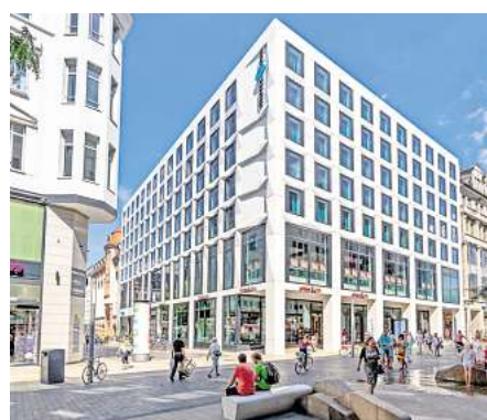
Kategorie Neubau: In der Grimmaischen Straße 29 öffnete Leipzigs zweites Motel-One-Hotel mit 180 Zimmern.
